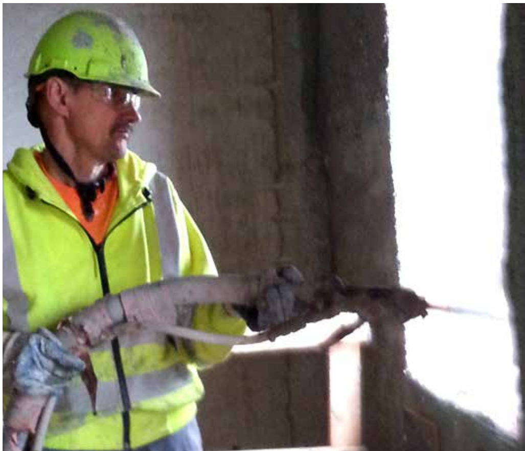
Vanha seinä paksunee kuopiolaaisessa suojelukohteessa uudella ruiskutyömenetelmällä. Jokaisen työvaiheen tarkka dokumentointi on tärkeää. Kuvassa oleva hanke ei liity jutussa kerrotuihin virheisiin.
