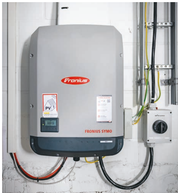
➡ Auringon tuottama sähkö johdetaan tähän invertteriin vasemmalla puolella sijaitsevia johtoja pitkin, ja oikealta puolelta sähkö jatkaa järjestelmässä eteenpäin.
