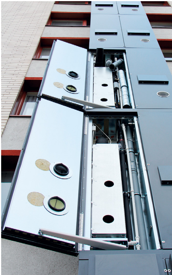
Talon ulkoseinustalla oleva talotekniikkahormi on helppo huoltaa.
