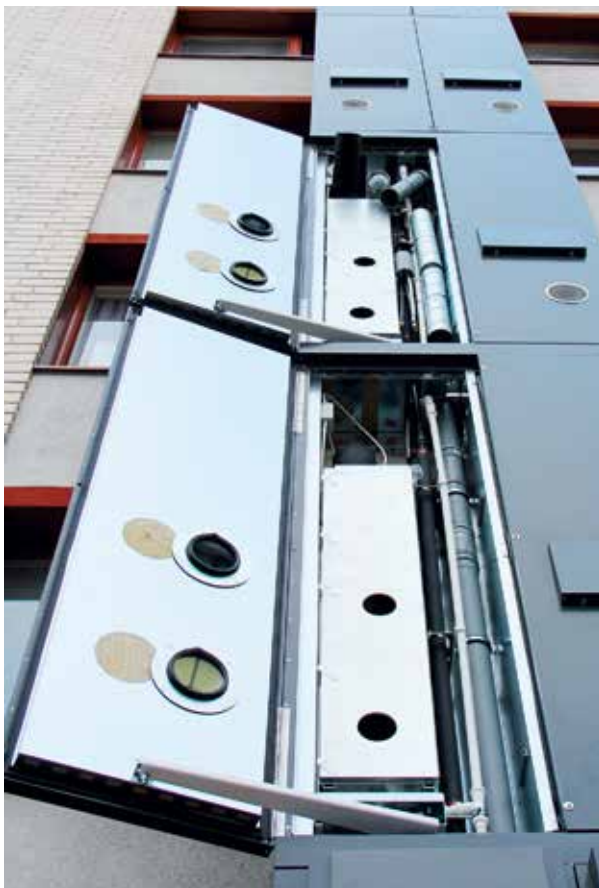
Talon ulkoseinustalla oleva talotekniikkahormi on helppo huoltaa.
