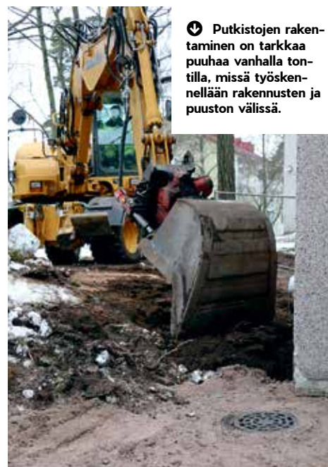
🔧 Piharemontin aikana rakennettiin kokonaan uusi putkisto ja kaivot, joiden välityksellä hulevedet johdetaan kaupungin sekavesiviemäriin.
