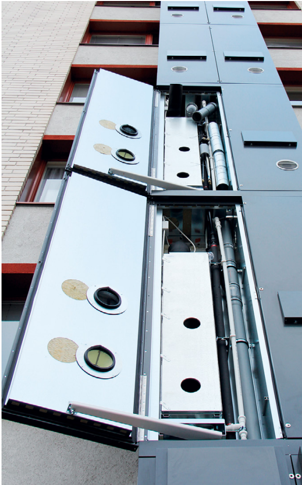
Talon ulkoseinustalla oleva talotekniikkahormi on helppo huoltaa.
