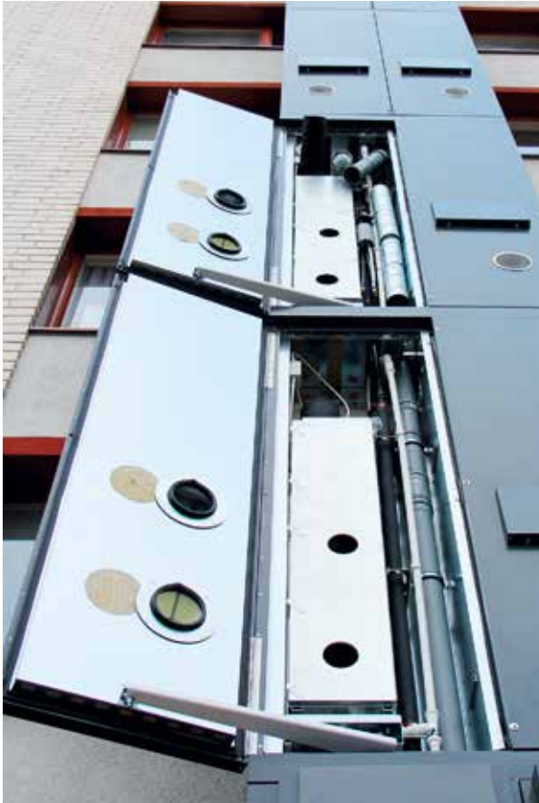
Talon ulkoseinustalla oleva talotekniikkahormi on helppo huoltaa.
