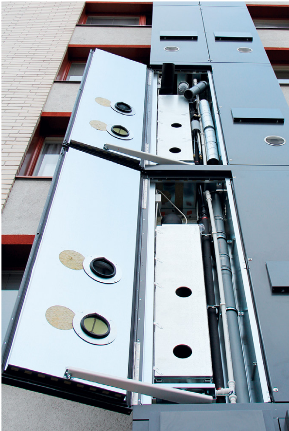
Talon ulkoseinustalla oleva talotekniikkahormi on helppo huoltaa.
